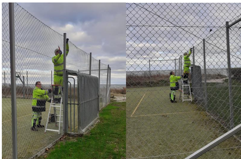
Eksempel på vedligehold af hegn som forlænger hegnets forventede levetid.
